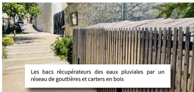
Les bacs récupérateurs des eaux pluviales par un réseau de gouttières et carters en bois
