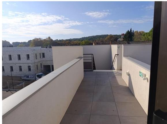
Ecart 9 : L'absence de sécurisation de nombreuses fenêtres, balcons et espaces extérieurs au 1<sup>er</sup> et au 2<sup>ème</sup> étage ne permet pas garantir la sécurité des résidents en empêchant les chutes, contrevenant à l'obligation de sécurité prévue à l'article L.311-3 du CASF. Ce manque de sécurisation est d'autant plus important qu'un résident est décédé par défenestration au moins de juillet 2024.
