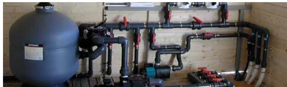
> **La désinfection** : le désinfectant détruit les germes présents dans l'eau et évite le développement des algues. Il est injecté au niveau du circuit de recirculation après filtration mais jamais directement dans le bassin :
