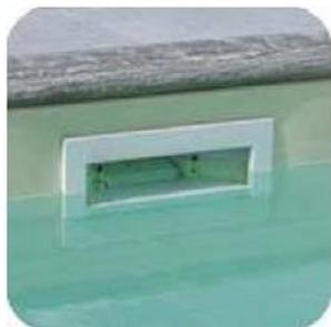
> **La recirculation permanente avec une hydraulité inversée ou mixte de l'eau du bassin**: reprise des eaux contaminées au moins à 50 % (renouvellement du film d'eau superficiel qui est la partie où se trouve le plus de germes).
